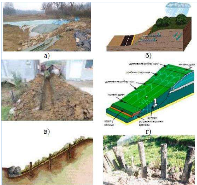
Слика 50. Хитне мјере санације: а) прекривање најлоном, б) постављање хоризонталних дренажа и канала, в) и г) [24]), д) прерасподела маса, ђ) и е) забијање кочева
