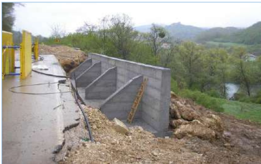
Слика 52: Изградња потпорног зида
