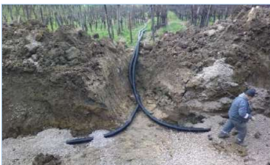
Слика 53. Дренажа клизишта као трајна мјера заштите.
