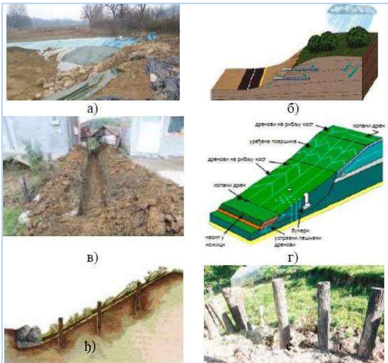
Слика 50. Хитне мјере санације: а) прекривање најлоном, б) постављање хоризонталних дренажа и канала, в) и г), д) прерасподјела маса, њ) и е) забијање кочева
