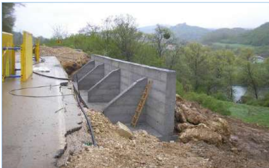
Слика 52. Изградња потпорног зида.
